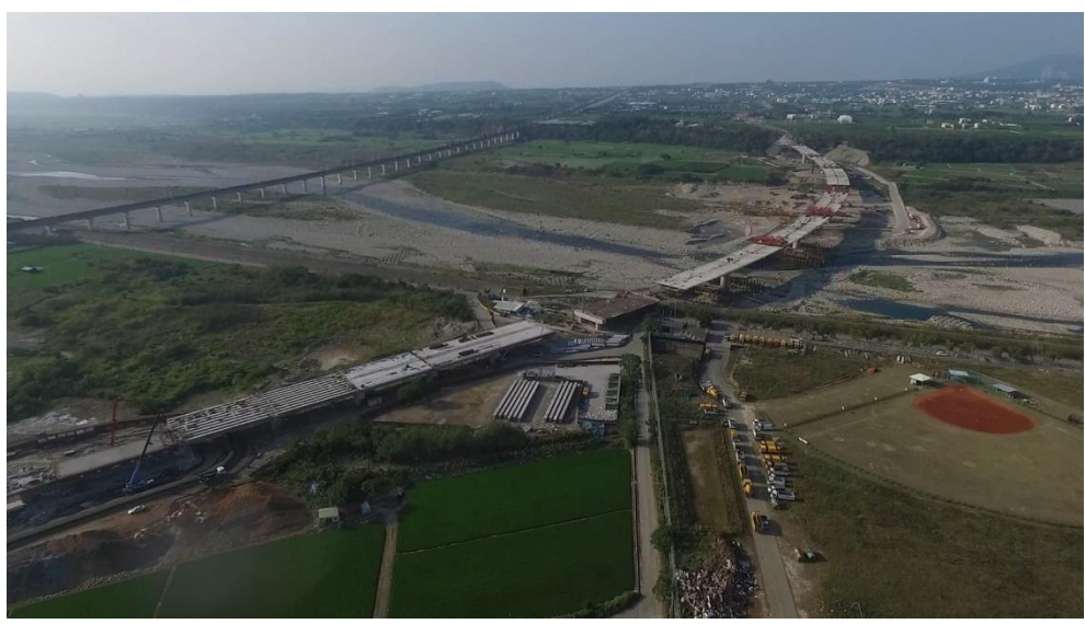
現場施工空拍照片
