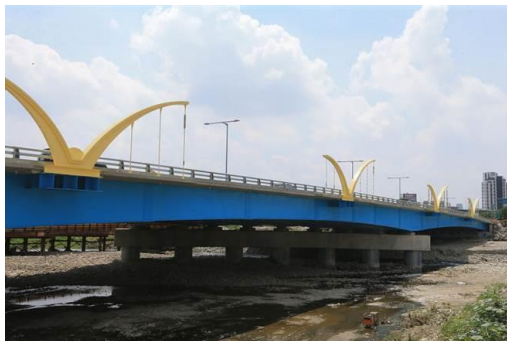
完工通車照片
