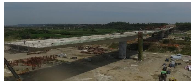
現場施工照片2
