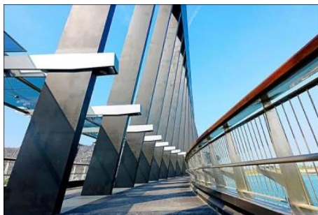
景觀橋完工照片2
