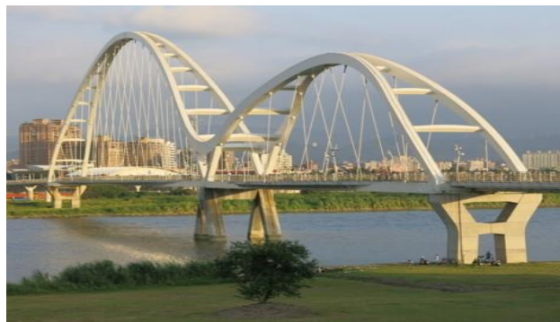
新月橋完工照片
