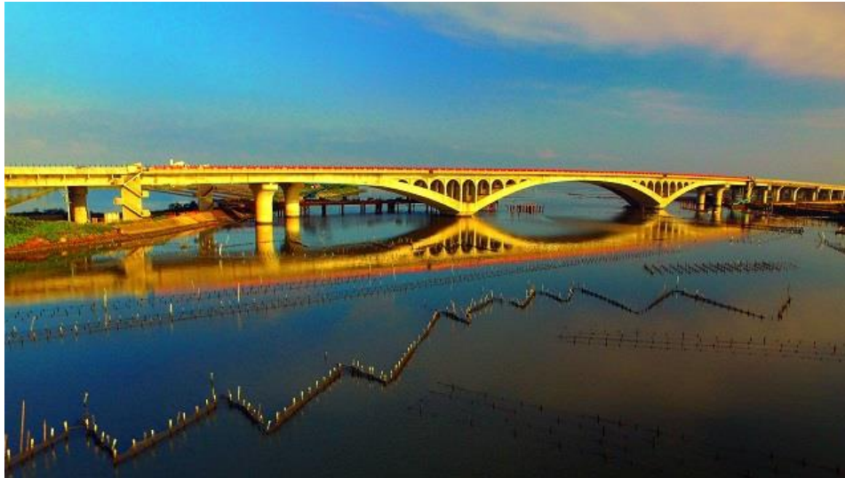
加勁式拱橋水中倒影 (西濱快速道路網站)
