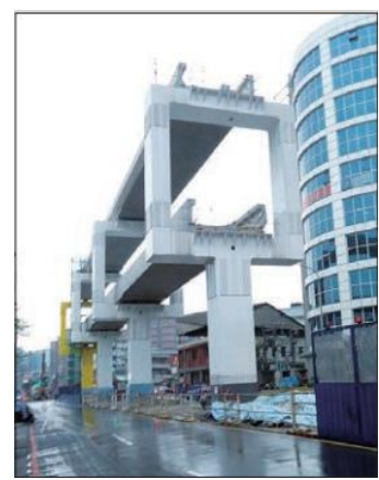
疊式鋼箱梁橋型示意照片
