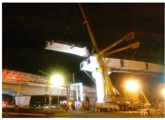
台中捷運北屯段吊掛橋梁
