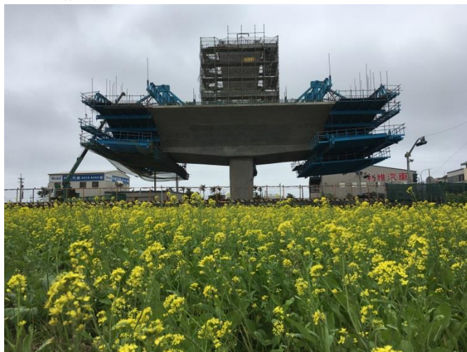
大甲大安段懸臂工法
