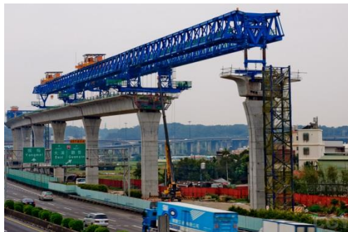
五楊高架預節塊吊裝法
