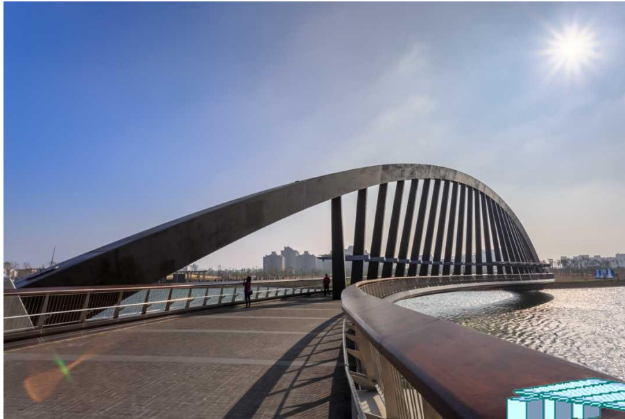
景觀橋完工照片1
