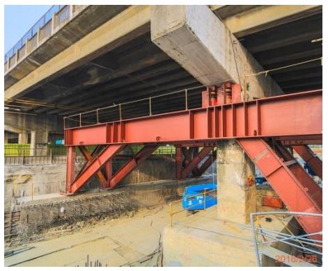
自強陸橋托底暫撐架施作
