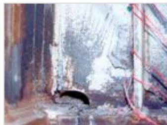
考慮到上部混凝土板的影響，將鋼連接部位的中性面向混凝土板的軸移動，鋼連接部位下部發生應力集中，由於上部混凝土板的影響抗震性能將會下降。
